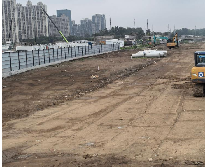
图2.4-2 临时占地现状
