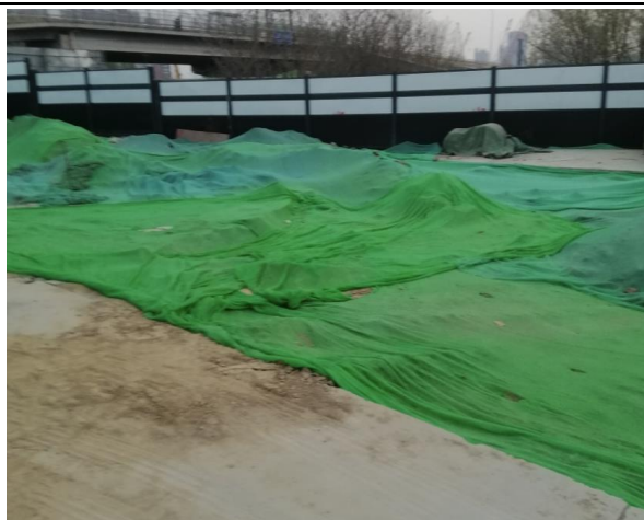
图 7-1 施工现场苫盖措施
