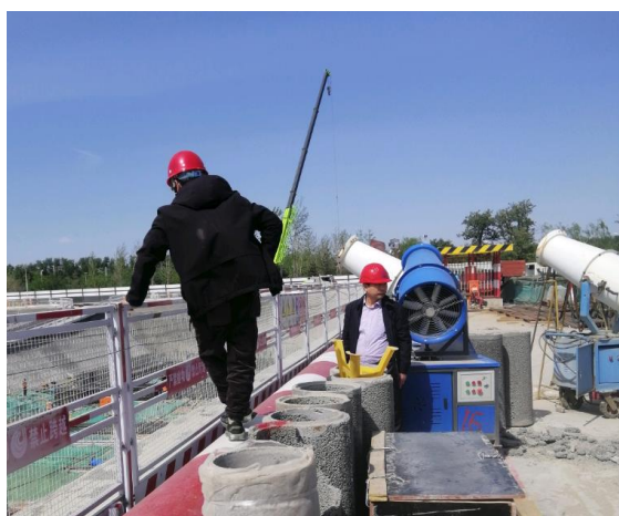
图 7-2 施工现场防尘措施
