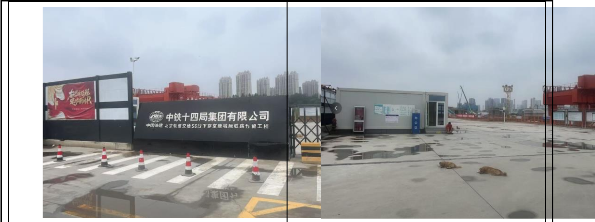
图 4-2 临时施工营地现状
