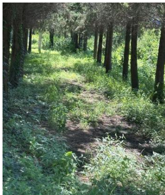
顺平路南侧配水管线恢复
