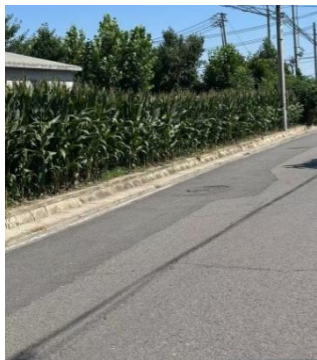
道路施工恢复情况
