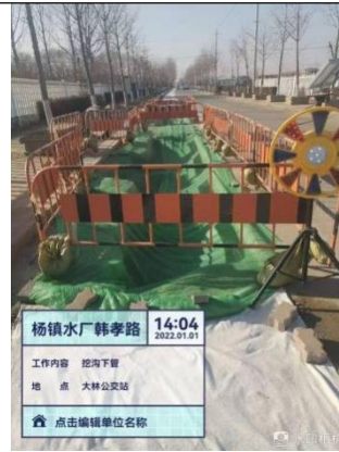
施工场地覆盖
