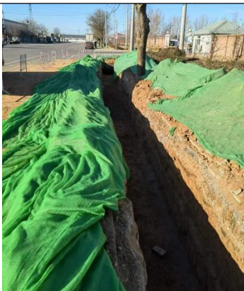
施工场地覆盖
