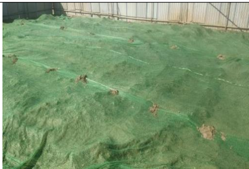
施工场地覆盖
