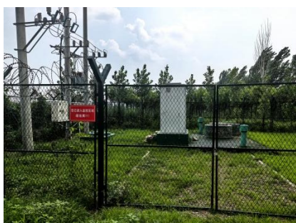
取水泵房绿化
