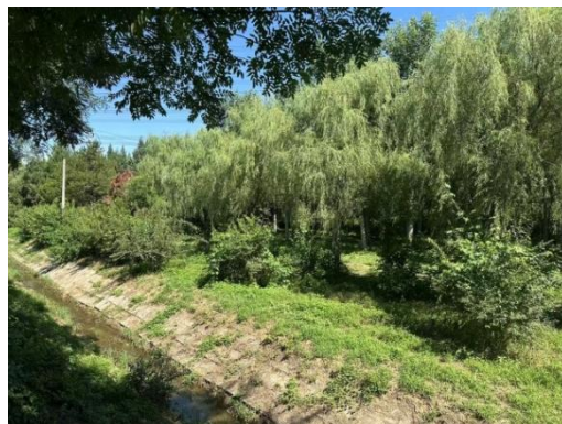
顺平路南侧配水管线恢复
