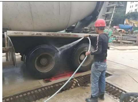
驶离工地车辆进行清洗
