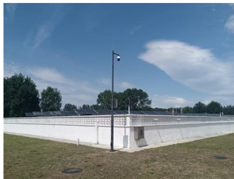
水厂水池周边恢复
