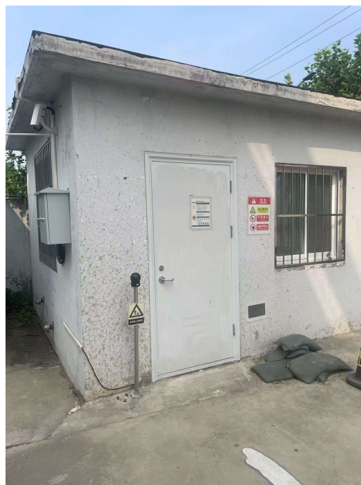
医疗废物储存间（拆除）
