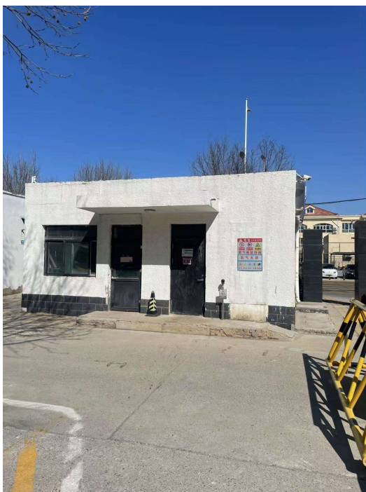
污水处理站（拆除）
