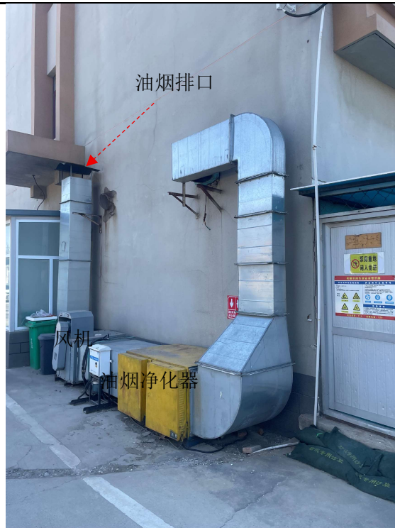
图 2-17 现状油烟排口照片
