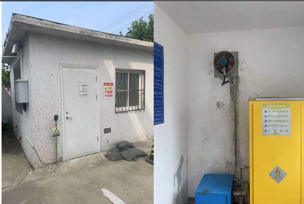
图 2-18 医疗废物暂存间现状照片
