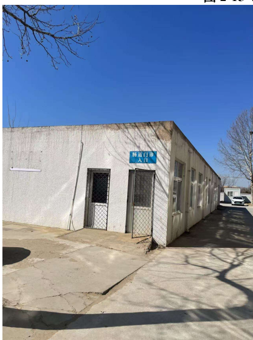
发热门诊（拆除）
