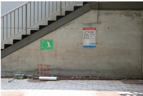
污水处理装置及污水总排口标识
