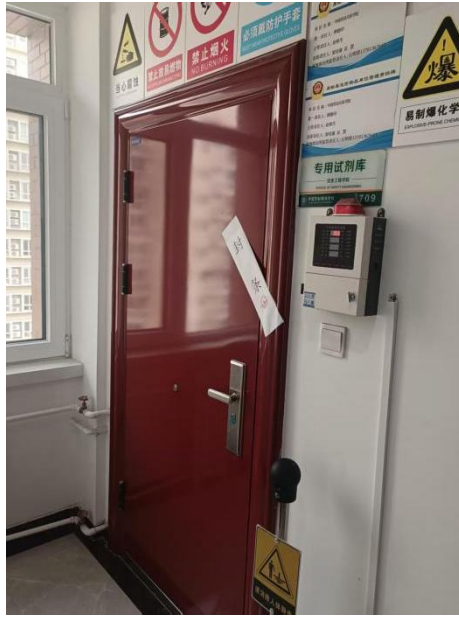
危化品间及监控装置
