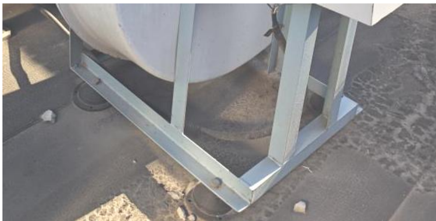
室外风机进行减振处理
