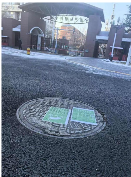
污水总排口标识
