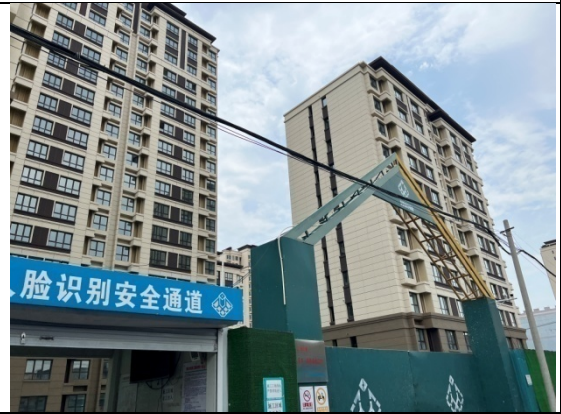
原幸福小区，现已拆迁， 目前正在建设回迁楼二期项目
