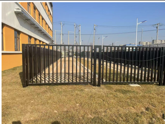
后续空气热泵安装区域
