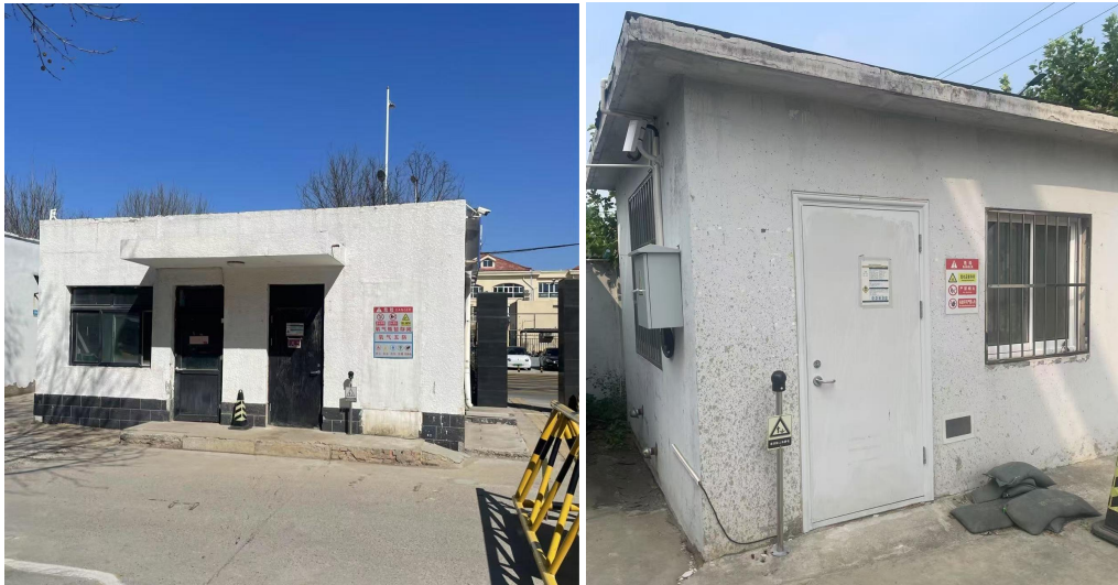
污水处理站（拆除）
