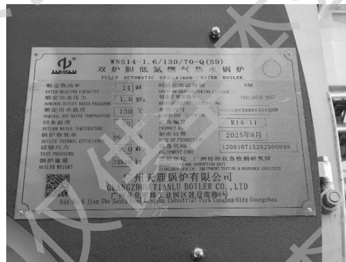
14MW 燃气热水锅炉
