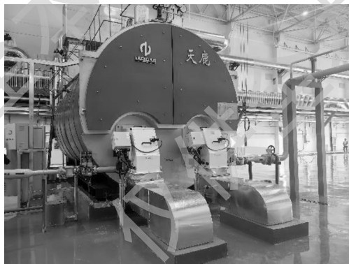
14MW 燃气热水锅炉
