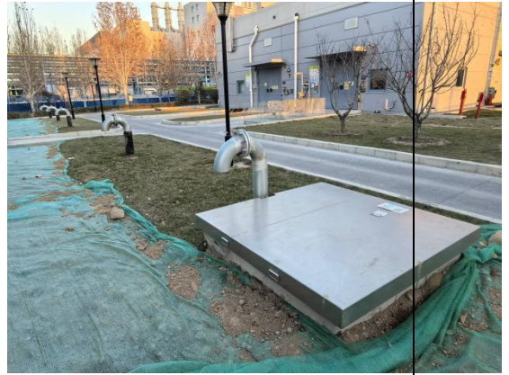
事故应急水池（化学品库）
