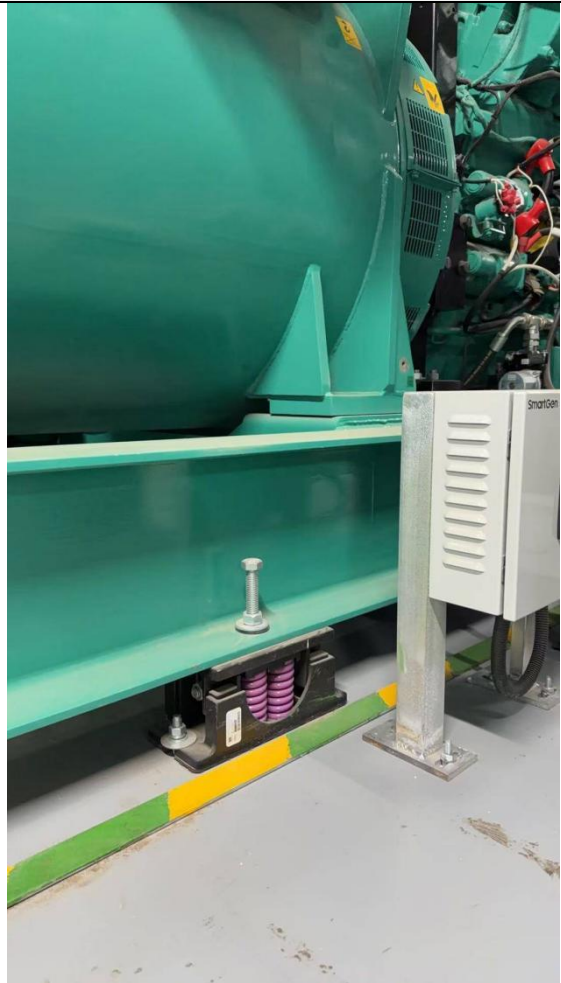
柴油发电机防振垫圈
