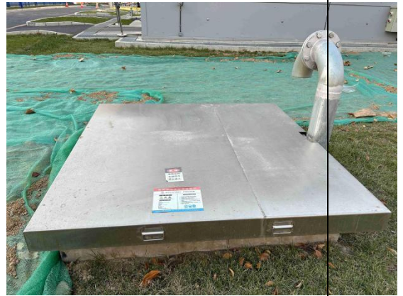
消防废水收集池
