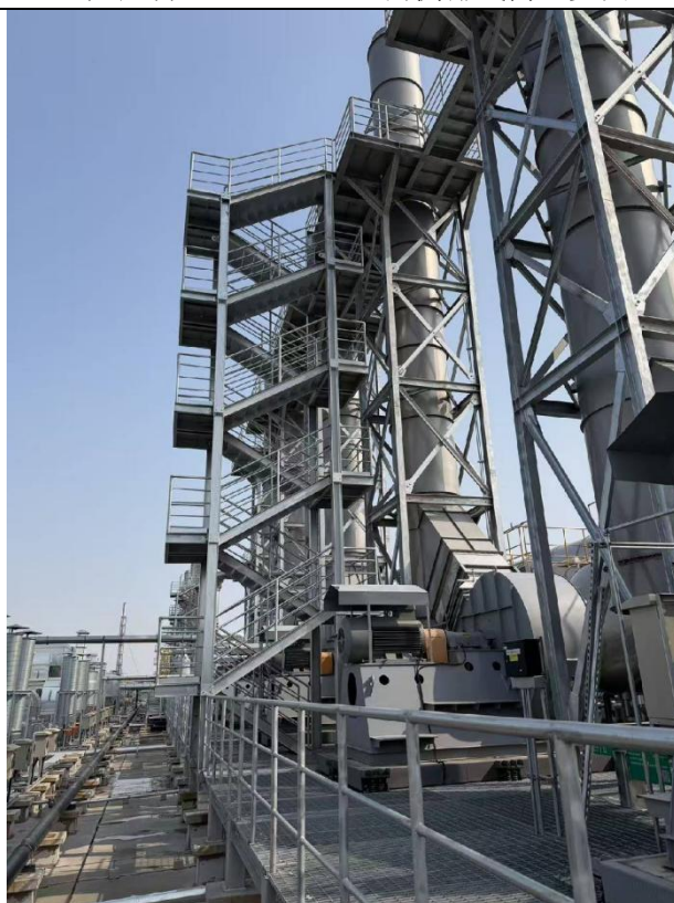
生产厂房 3（FABC1C）北侧排气筒总览图
