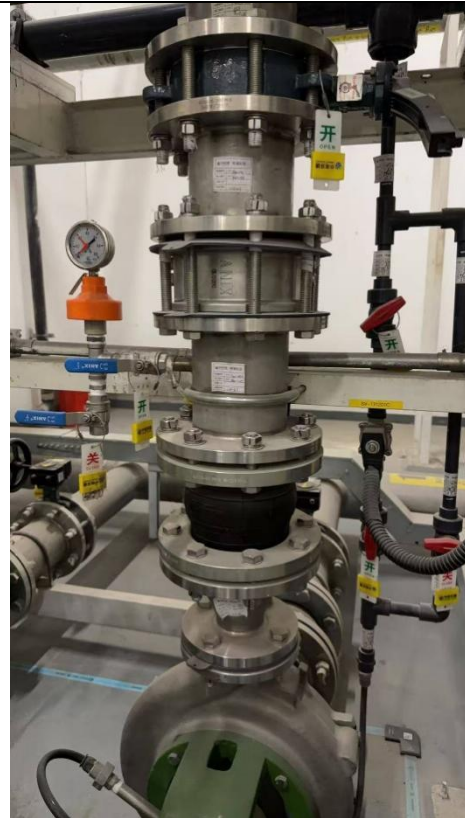
橡胶接头减震（水泵吸水管和出水管）
