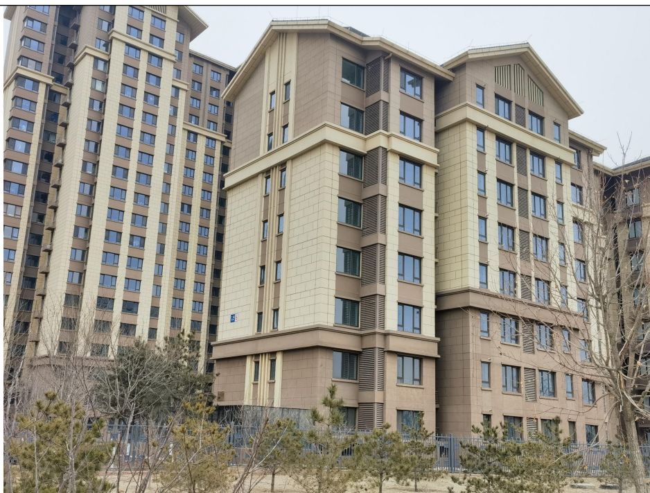
清韵北里二区 6 号楼（8 层）（原古月佳园置换房 17#）
