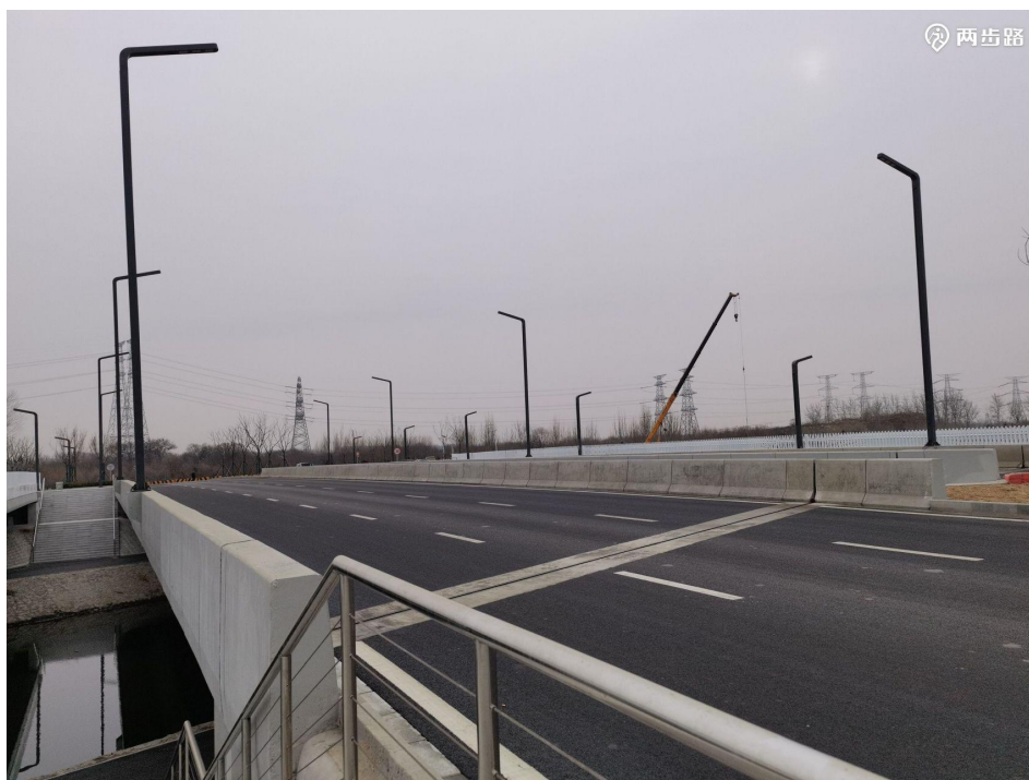
图 4.4 本项目减运沟桥梁现状图
