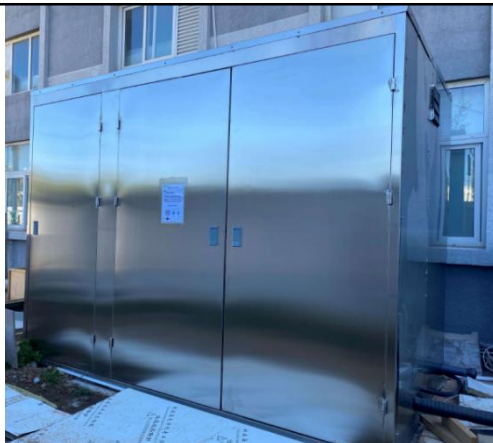
现状污水处理站
