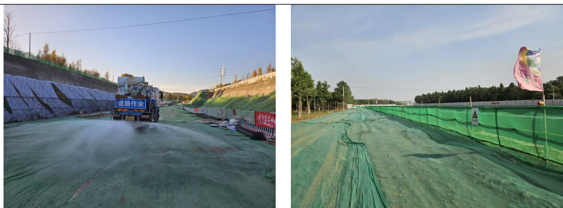
图 5-1 施工期间洒水、苫盖等措施
