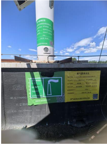
DA001 排气筒排放口标识
