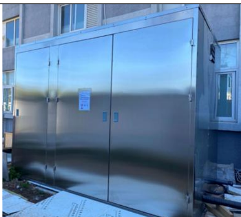
现状污水处理站
