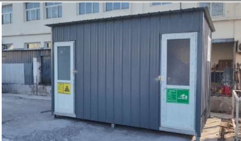
危废间及一般固废间
