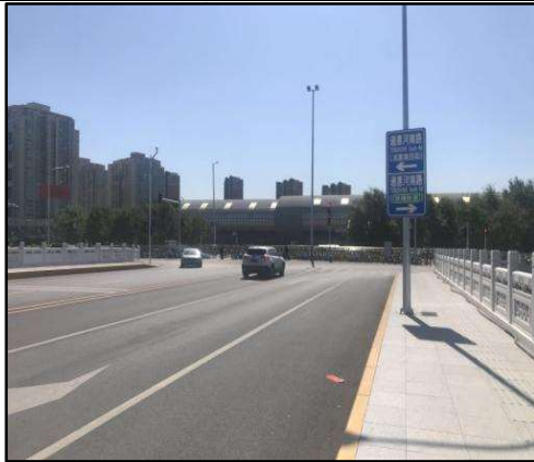
起点（京通快速北辅路）
