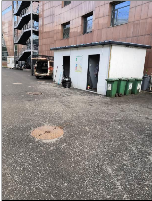
图 9-1 项目所在建筑西侧室外的垃圾暂存间及设施
