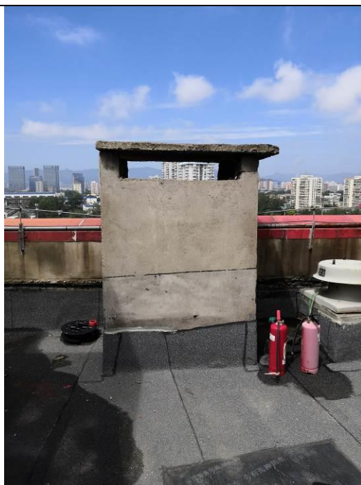
图 7-4 位于 8 层楼顶西北侧的油烟排放口
