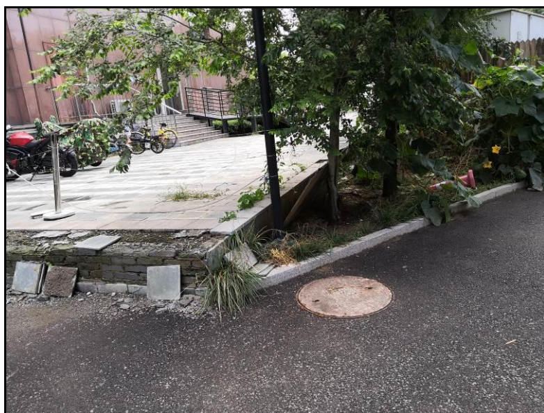
图 6-1 位于项目所在院区内西侧的污水总排口
