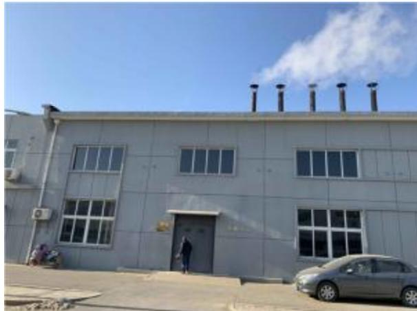
图 3-1 锅炉房排口照片（本项目利用其中 4 个排气口）
