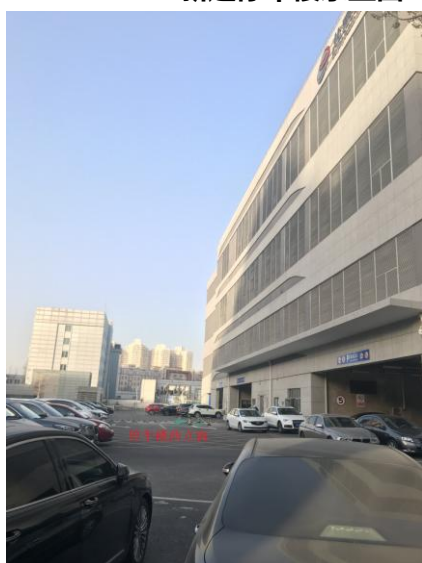
新建停车楼西立面
