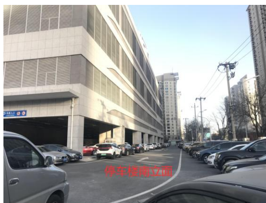
新建停车楼南立面
