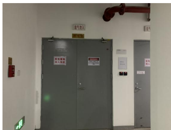
地下一层设备间
