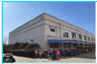
项目西侧 3 号厂房现状
