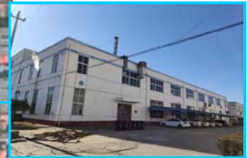
项目南侧 1 号厂房现状
