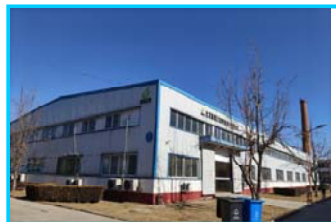
项目北侧 7 号厂房现状
