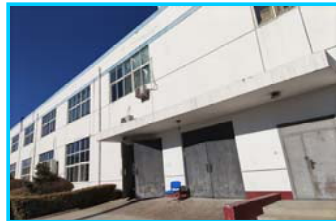
本项目所在 2 号厂房现状
