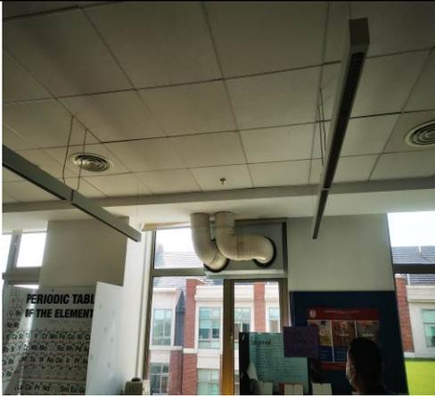
图7 实验室废气排口
