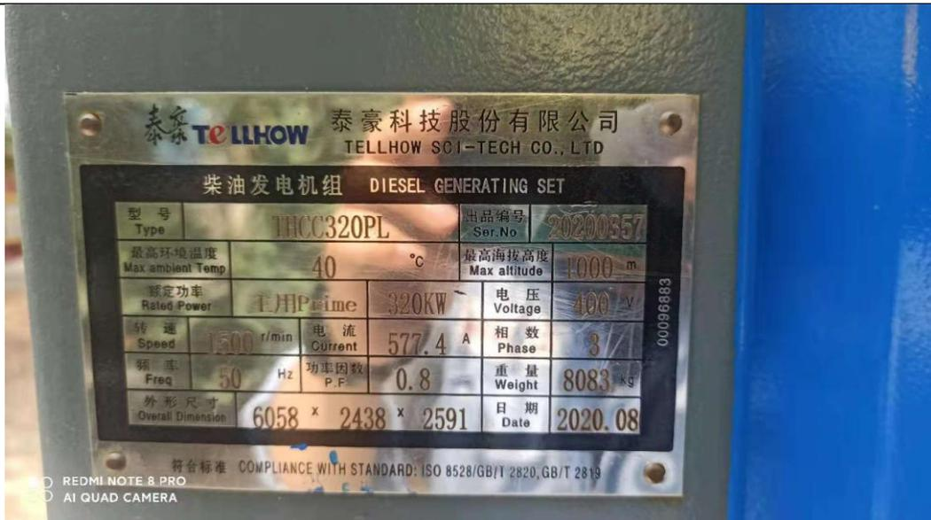
本项目柴油发电机组选用的是泰豪科技股份有限公司生产的 THCC320PL 型机组，机组发电机使用的是重庆康明斯发动机有限公司生产的 QSNT-G3 型发动机。
