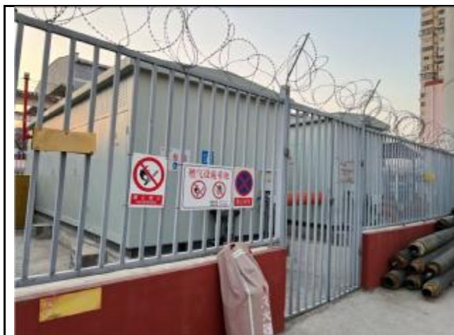
图 12 改造后的调压站
