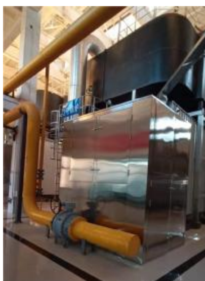
2#锅炉燃烧器隔声罩
