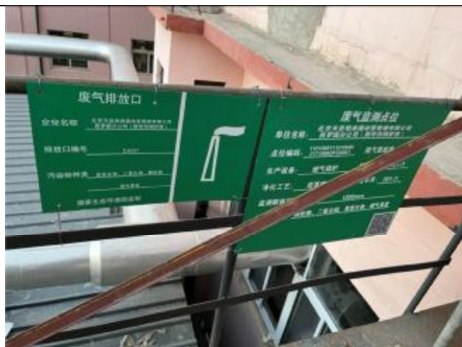
1#锅炉排放口标识
