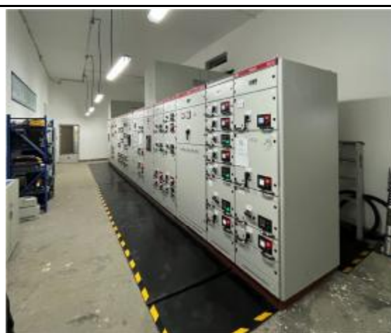
图 13 改造后的变电室
