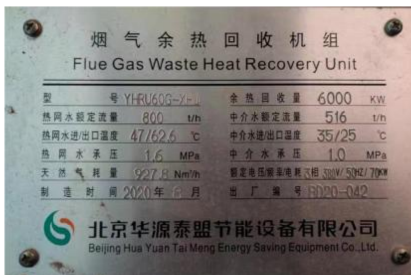
图 16 余热回收机组铭牌
