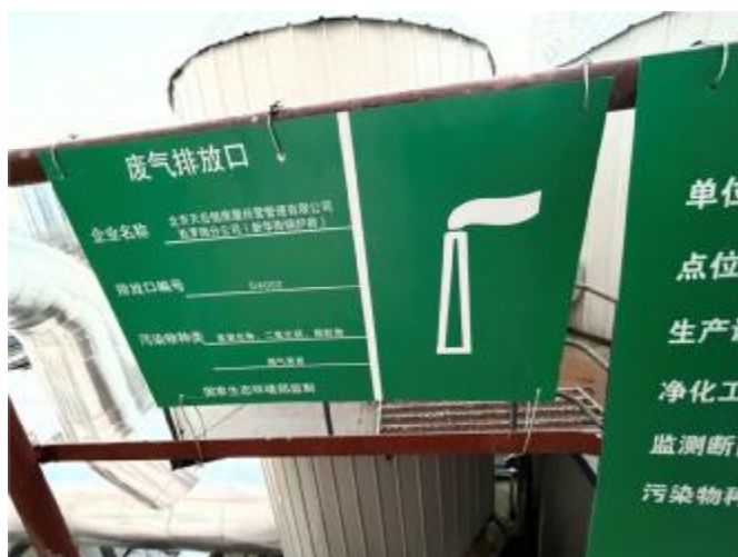
2#锅炉排放口标识
