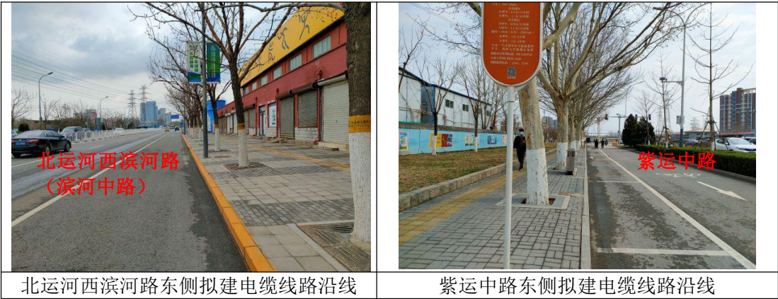
图2-3 项目输电线路沿线现状图
