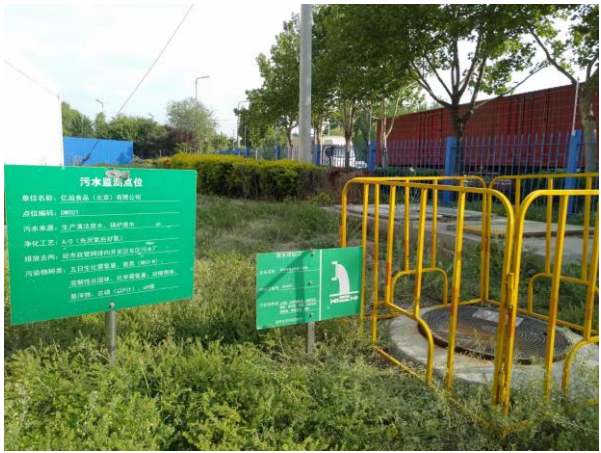
厂区污水总排口照片
