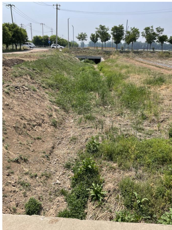
(2) 大兴庄四支渠汇入大狼堡沟处现状
