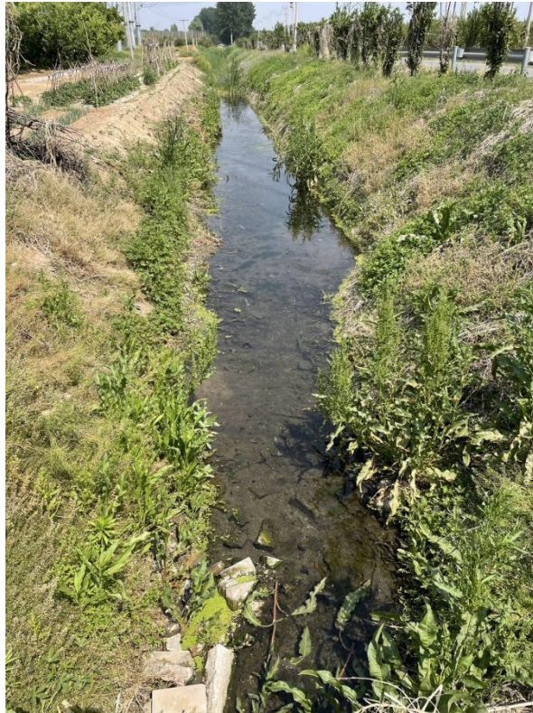
(1) 污水站退水口处大兴庄四支渠现状
