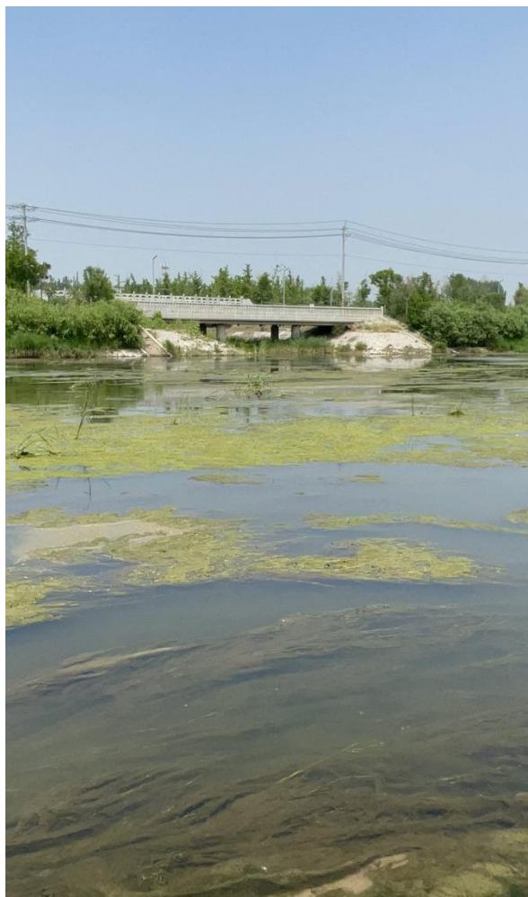
(4) 大狼堡沟下游永兴河现状
