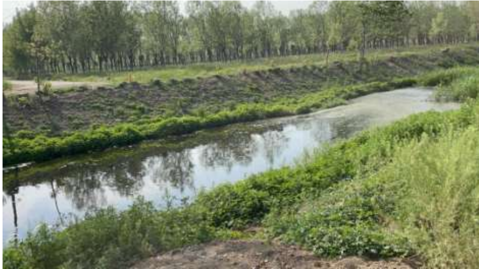
(1) 污水站退水口处田营沟现状
