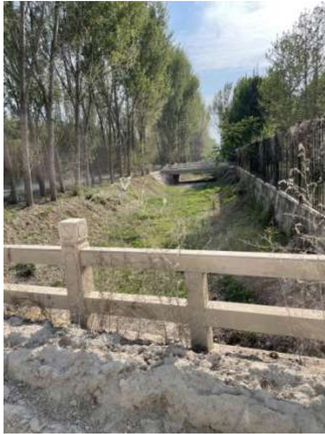
(2) 与永北干渠交汇口上游田营沟现状
