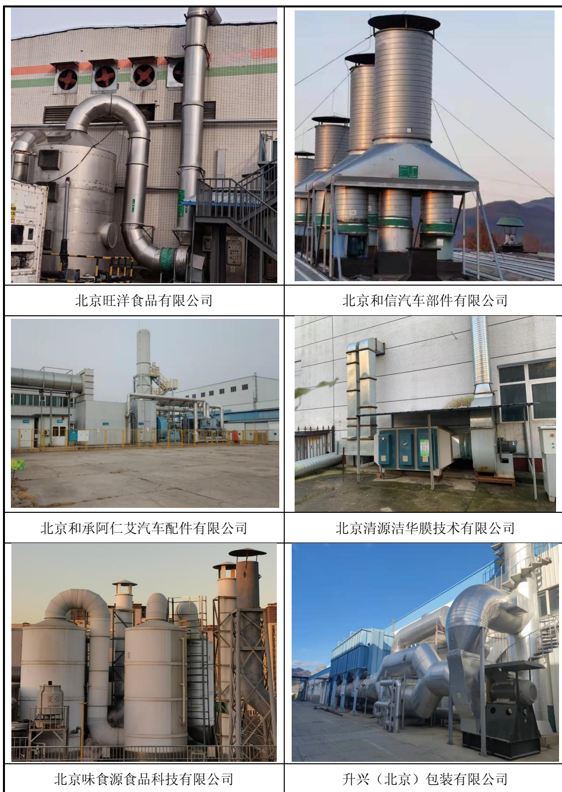
图2.3-2 开发区内部分企业废气治理措施现场照片
