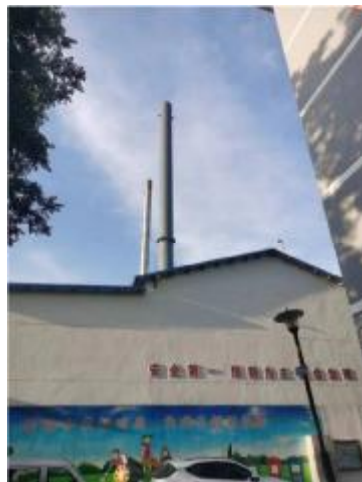
现状锅炉房烟囱
