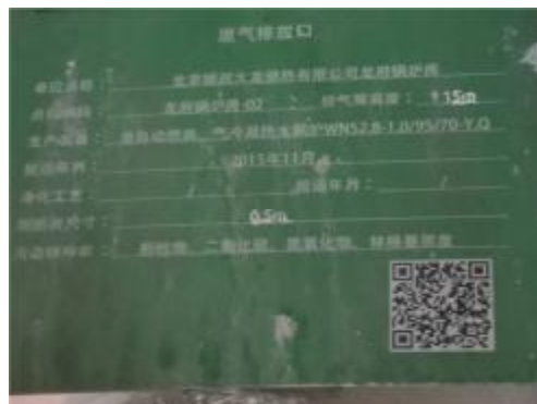
2.8MW 锅炉废气排放口标识
