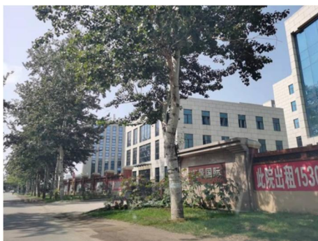
项目北侧云景国际写字楼
