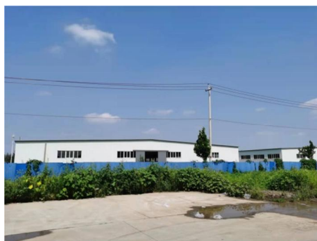
项目东侧厂房
