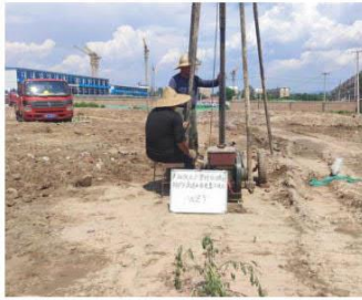
图 4-42 WZ9 钻探施工
