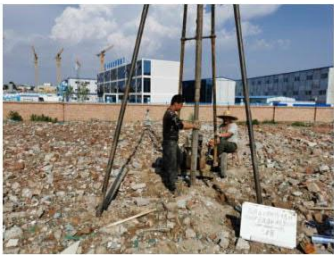
图 4-20 SZ8 钻探施工
