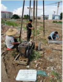
图 4-24 SZ10 钻探施工
