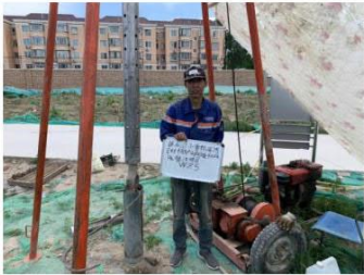
图 4-34 WZ5 钻探施工
