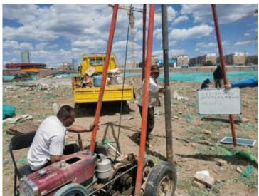
图 4-28 WZ2 钻探施工
