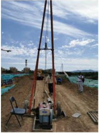
图 4-14 SZ5 钻探施工
