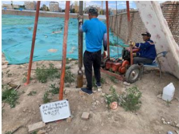
图 4-10 SZ3 钻探施工
