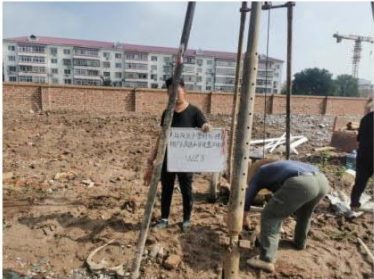
图 4-40 WZ8 钻探施工
