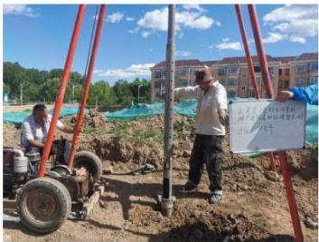
图 4-32 WZ4 钻探施工
