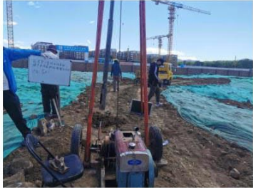
图 4-6 SZ1 钻探施工
