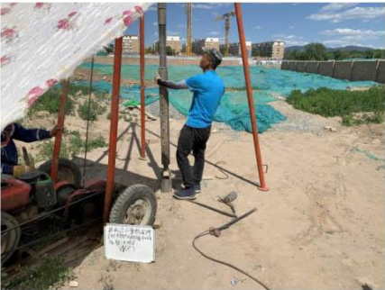
图 4-30 WZ3 钻探施工
