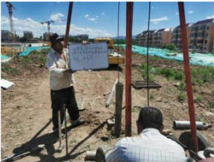
图 4-36 WZ6 钻探施工
