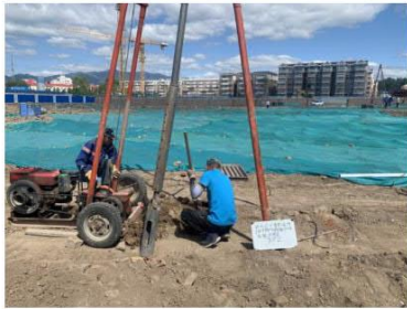
图 4-8 SZ2 钻探施工
