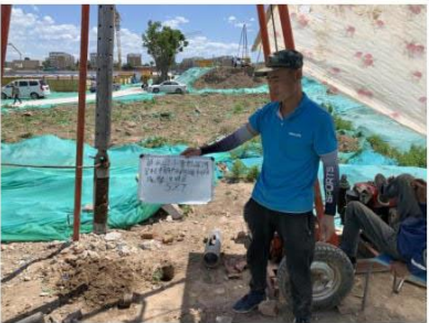
图 4-18 SZ7 钻探施工
