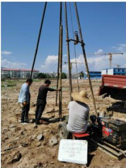
图 4-22 SZ9 钻探施工
