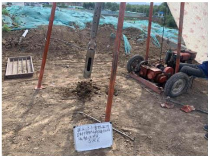
图 4-16 SZ6 钻探施工
