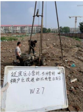
图 4-38 WZ7 钻探施工
