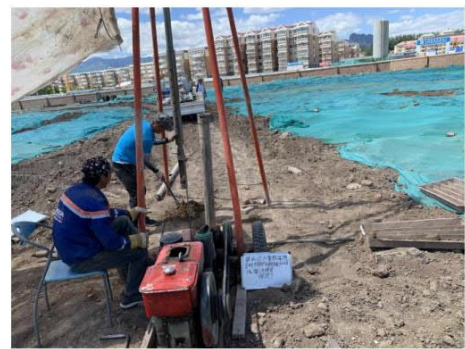
图 4-26 WZ1 钻探施工
