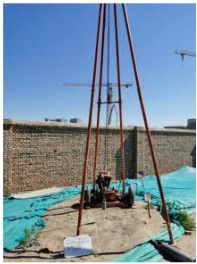
图 4-12 SZ4 钻探施工
