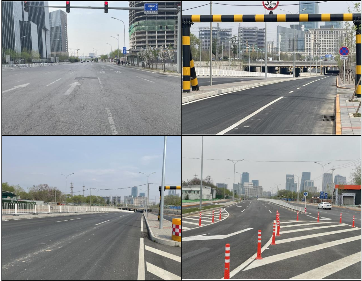
图2.3-1 道路现状照片
