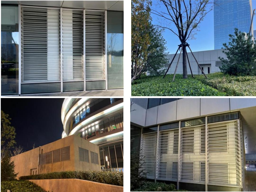
图9 地下车库废气排风口
