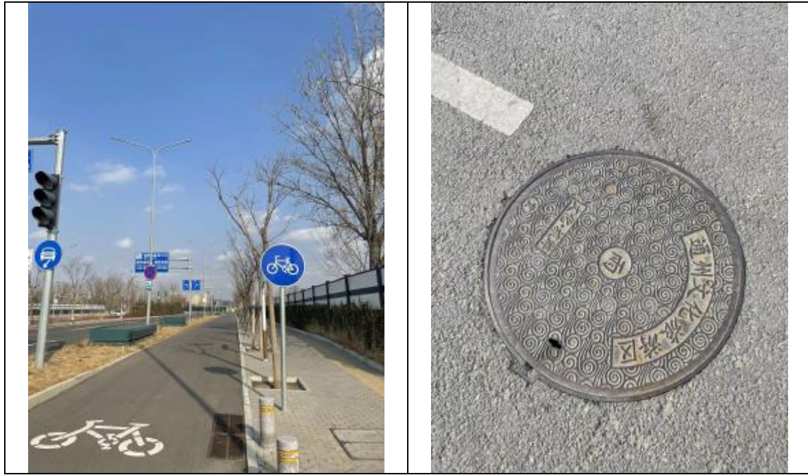
图 5.4-1 沿线排水工程照片
