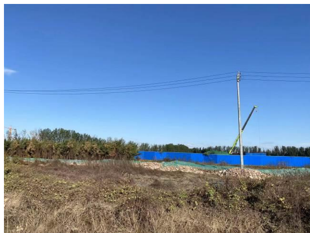
北侧施工场地
