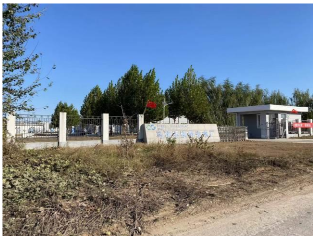
东侧马驹桥镇再生水厂
