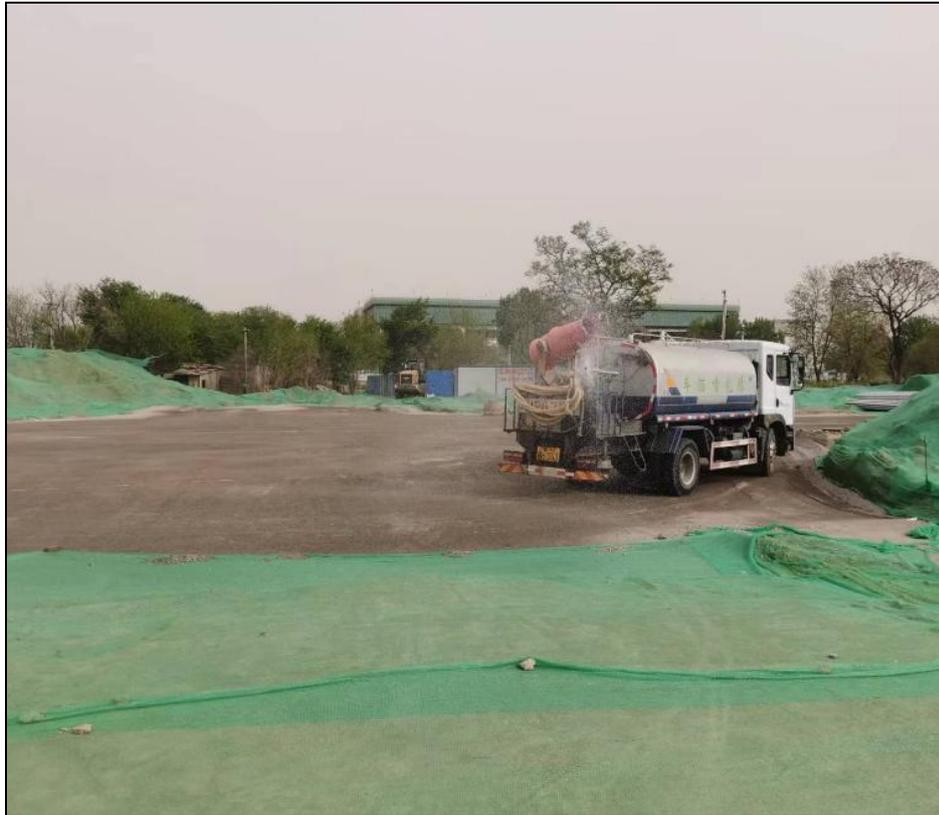
图 7-1 施工期洒水抑尘照片
