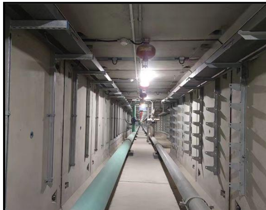
综合管廊内部
