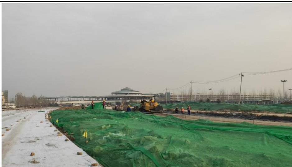
图 7-1 施工期场地苫盖照片
