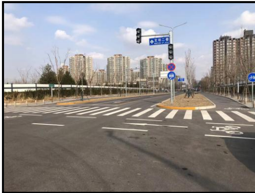
地面现状道路
