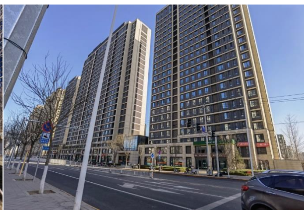
南侧泰安路及西山燕庐东区
