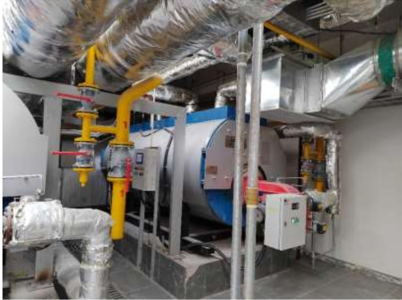
图5 锅炉基础减振
