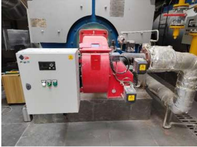
图 5 锅炉低氮燃烧器照片
