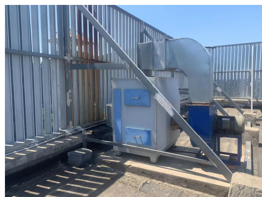
图 3-2 废气净化设施及标识图片
