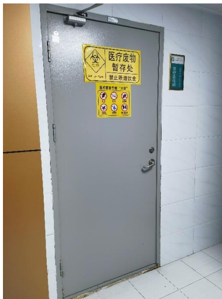
图 3-5 医疗垃圾暂存间
