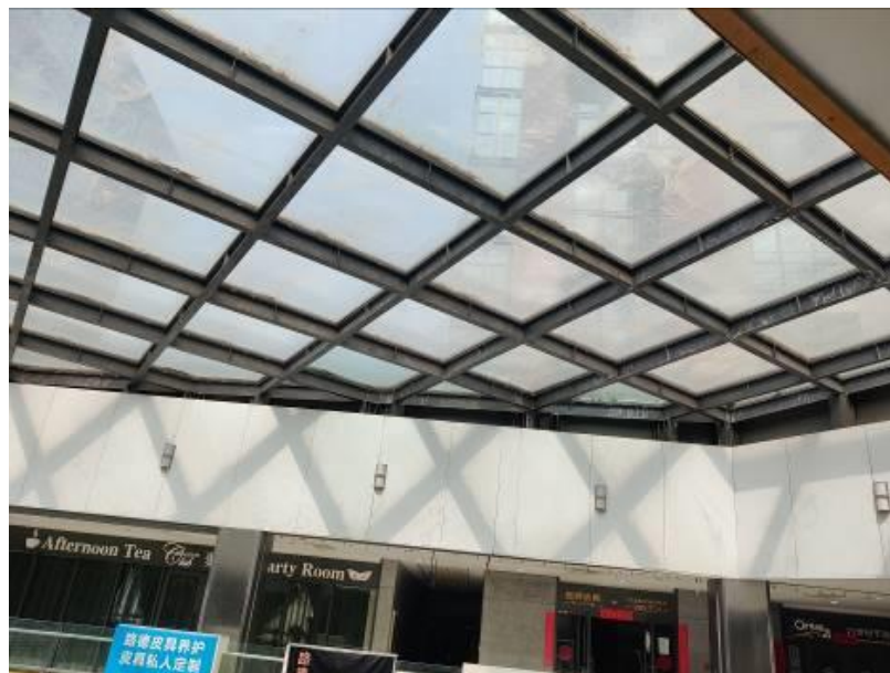
图7 二层商业玻璃挡墙照片
