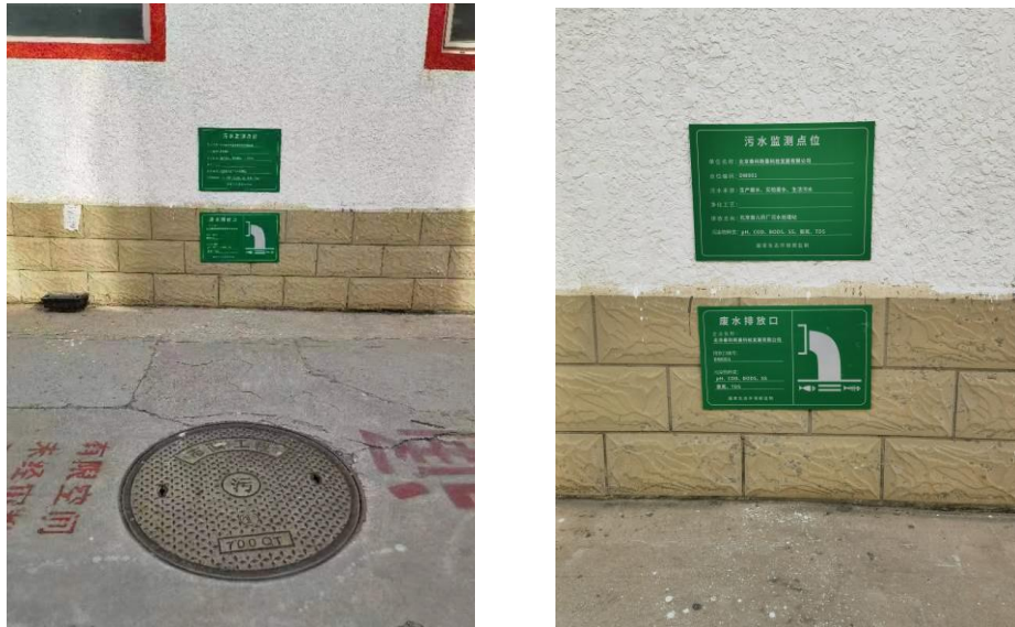
污水总排口及监测点位
