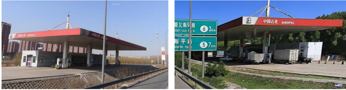
图 3-33 中石化李桥西、东加油站现状照片
