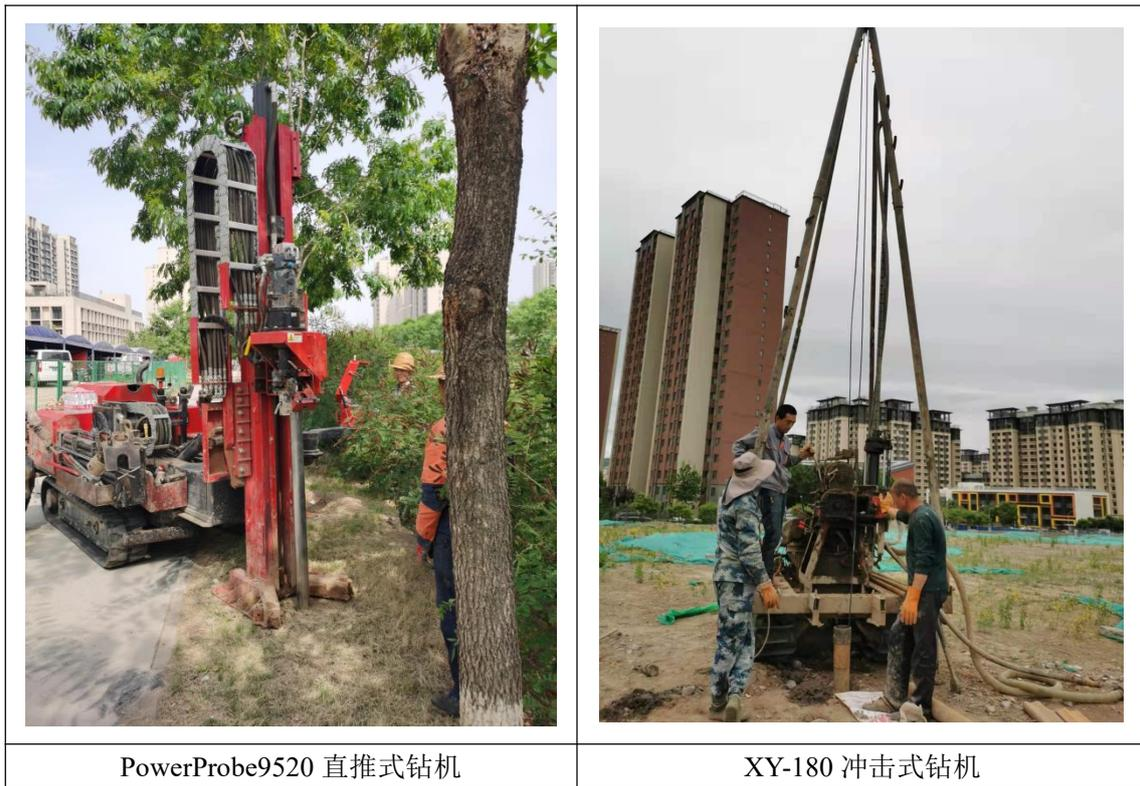
图 6.2-1 现场钻探照片
