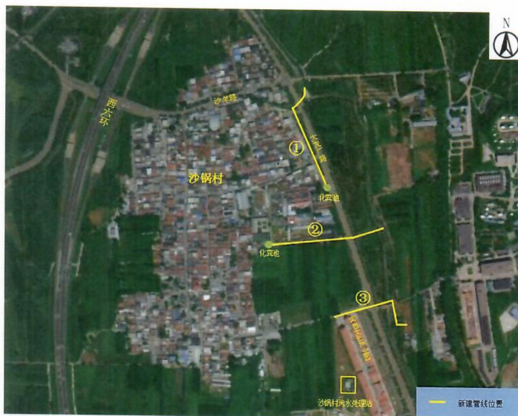
图4 沙锅村新建污水管线
