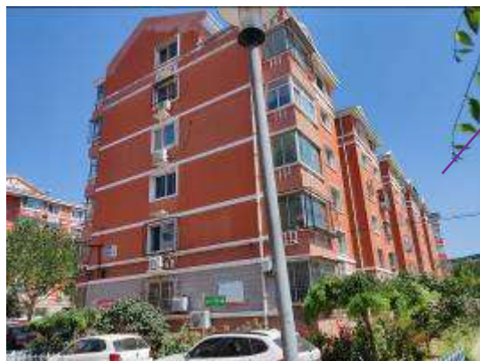
西侧：燕水佳园16号楼
